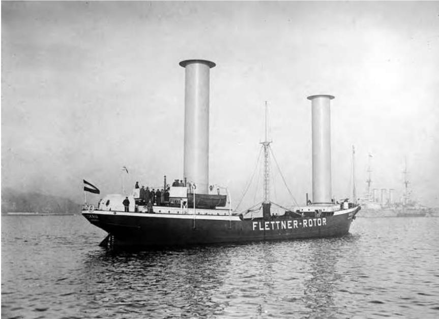
Рисунок 18. Парусное судно «Букау» с установленными на нем роторами Флеттенера
